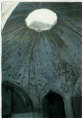
سقف و تیرگیر گرمخانه
