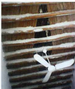
توفال کاری سقف اتاق ضلع جنوبی
