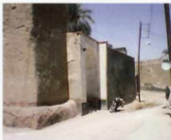
درب ورودی در ضلع شمالی
