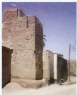
دیوار شمالی خانه علی یار سپیدآسا
