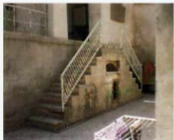
پله های ایوان شرقی
