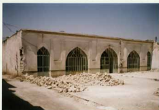
تصویر 1- نمای کلی بنای مسجد میر غلامعلی دید از شرق؛ ف.7.ن.1-1
