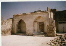
تصویر 2- نمای کلی درب ورودی و تخریب دیواره ضلع شرقی بنای مسجد میر غلامعلی دید از جنوب؛ ف.7.ن.2-1
