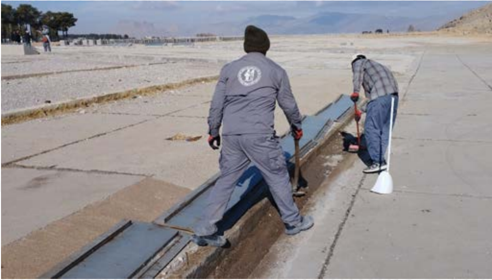
پاکسازی مسیر خروجی آب و منحول مقابل پلکان ورودی مجموعه
