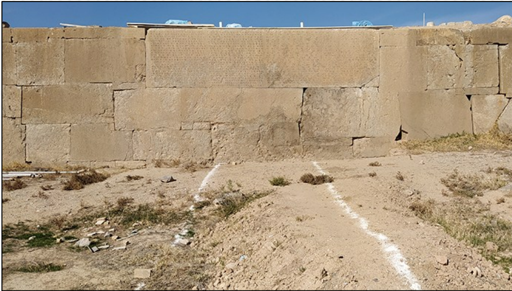
بخشی از نمای جنوبی تخت گاه و کتیبه سه زبانه داریوش پس از برداشتن سایه بان موقت
