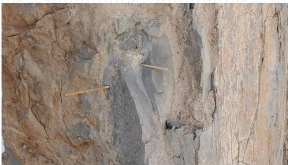
مشخص کردن محل تزریق بوسیله سیخهای چوبی
