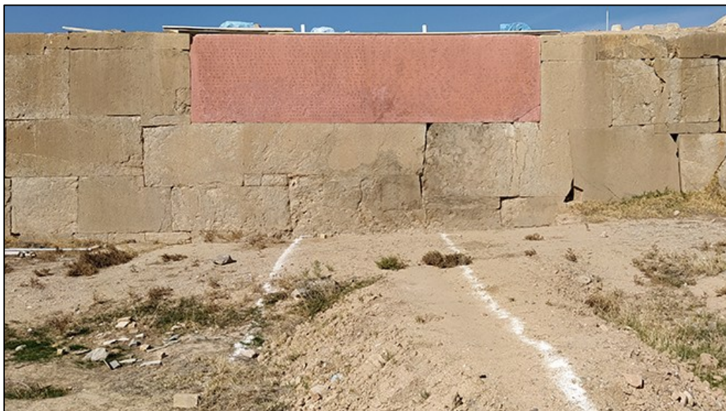
جانمایی کتیبه سه زبانه داریوش در دیوار جنوبی تخت گاه
