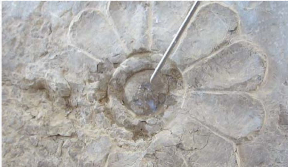
در حال تریق میکرواکریل در پلکان شرقی کاخ آپادانا
