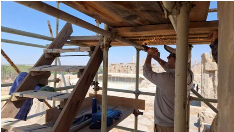
برش پیچها و میخهای اضافی سقف کارگاه جهت ایمن سازی فضای حرکتی
