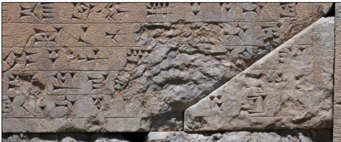
تصاویر آسیب‌های کتیبه - آسیب‌های اطراف یک وصله هخامنشی
