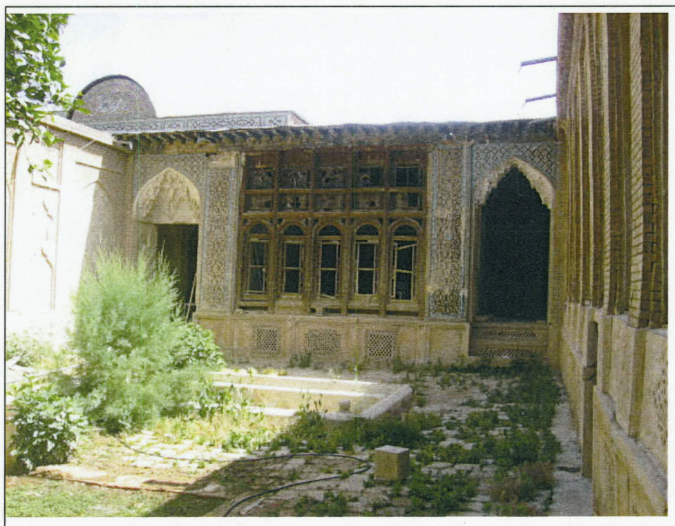
مکتبخانه ( خانه عرقیها ) ، نمای ضلع شمالی
